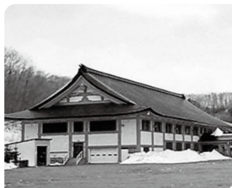
念法寺には災害時のための水や食糧が備蓄されています！
